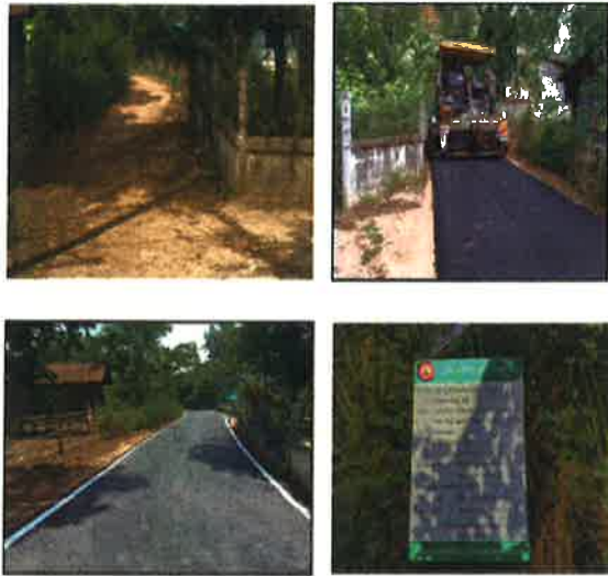
โครงการปรับปรุงผิวจราจรแอสฟัลติกส์คอนกรีต บ้านเสมาใหญ่ หมู่ที่ ๓ บริเวณจาก ศพต. บ้านเสมาใหญ่ ไปบ้านหนองสิขา การวาง (ข้อบัญญัติ)
