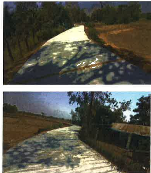
โครงการก่อสร้างถนน ค.ส.ล. บ้านหนองหัวช้าง หมู่ที่ ๗ บริเวณ นายสวัสดิ์ ไถนอกถึงบ้านนายทอง ประทุมนอก (ข้อบัญญัติ)
