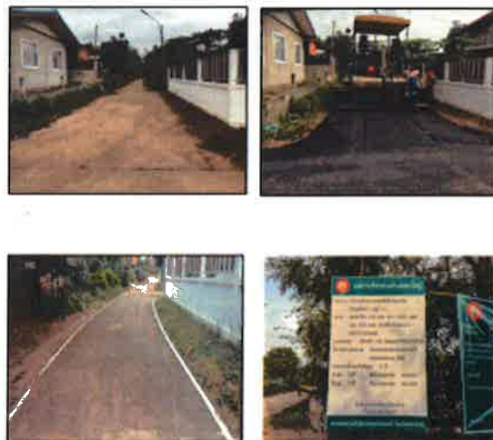
โครงการปรับปรุงผิวจราจรแอสฟัลต์ติกคอนกรีต บ้านแจ้งสว่าง หมู่ที่ ๑๑ บริเวณแยกบ้านนางสมจิตร์ ศรีคำไปบ้านนายบุญมี บรรดาศักดิ์ (ข้อบัญญัติ)
