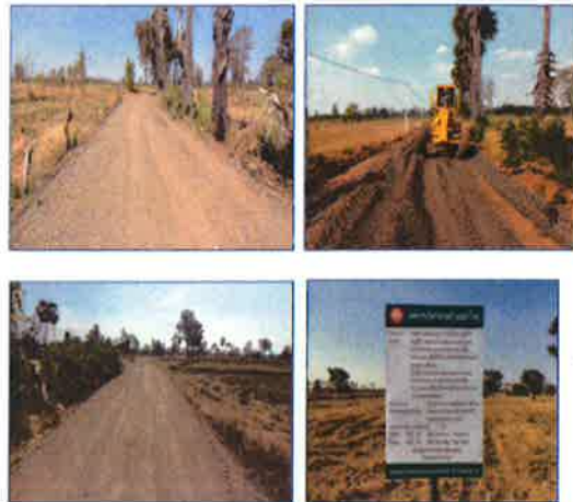
โครงการก่อสร้างถนนหินคลุก บ้านไร่อ้อย หมู่ที่ ๔ บริเวณเส้นทางจากหน้าวัดบ้านไร่อ้อยไป โคกหนองวงบ้านหนองจิ้งน้อย (ข้อบัญญัติ)
