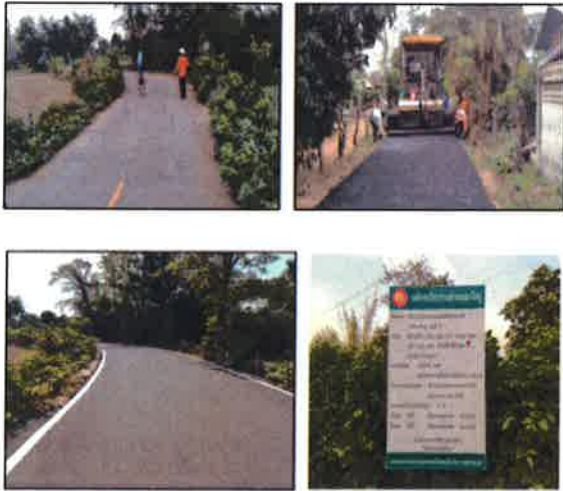
โครงการปรับปรุงผิวจราจรแอสฟัลต์ติกคอนกรีต บ้านโนนใหญ่ หมู่ที่ ๘ บริเวณจากของฉัตรยาควายถึงบ้านนางมโนรา (ข้อบัญญัติ)
