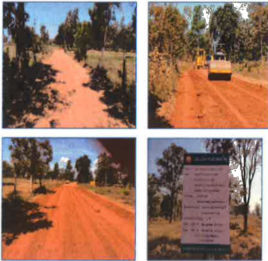
โครงการก่อสร้างถนนลูกรัง บ้านตอกบก หมู่ที่ ๔ บริเวณจากแยก ไปบ้านโนนนางาม ไป โคกโสภะหวาย (ข้อบัญญัติ)
