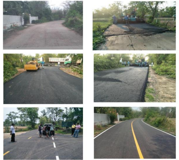
โครงการปรับปรุงผิวจราจรแอสฟัลต์ติกคอนกรีตบ้านโนนใหญ่ หมู่ที่ ๘ บริเวณจากบ้านนายอารีย์ การถาง ถึง สี่แยกช่องฉิดยาควาย (ข้อบัญญัติ)
