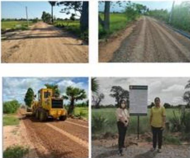
โครงการก่อสร้างถนนหินคลุก บ้านไร่ฮ้อย หมู่ที่ ๔ บริเวณจากหมู่บ้านไร่ฮ้อย ไปบ้านโนนดี (ข้อบัญญัติ)
