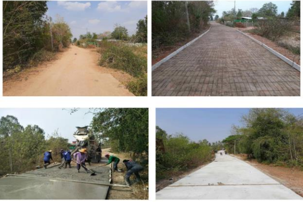
โครงการก่อสร้างถนน คสล.บ้านหนองช้าง หมู่ที่ ๗ บริเวณบ้านนายอุดม บุญนอก ไปประปาหมู่บ้าน (ข้อบัญญัติ)
