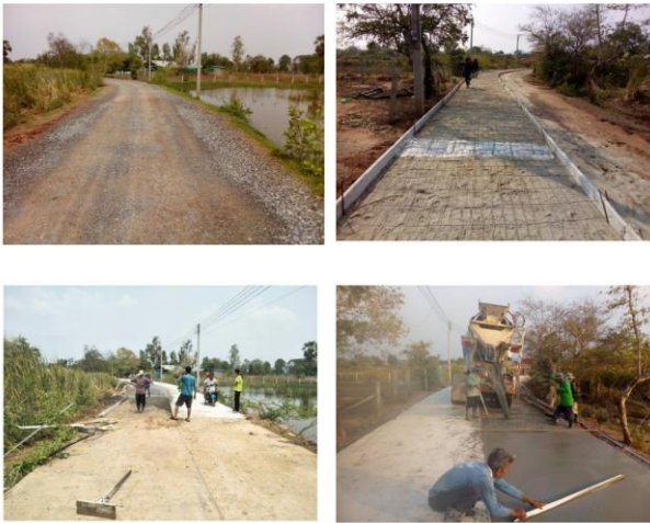
โครงการก่อสร้างถนน คสล.บ้านหนองหัวช้าง หมู่ที่ ๗ บริเวณสามแยกวัดบ้านหนองหัวช้าง ไป ท่าม่วง (จ่ายขาดเงินสะสม)
