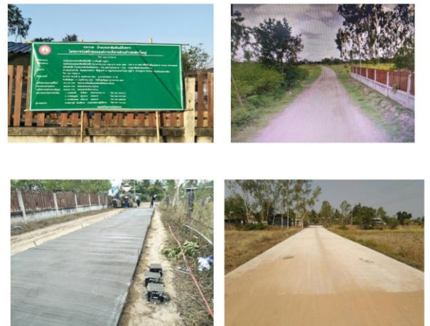
โครงการก่อสร้างถนน ค.ส.ล.บ้านโนนดัว หมู่ที่ ๖ บริเวณจากบ้านนายอดุลย์ กุพันธ์ ถึง โรงเรียนบ้านหนองแจ้จ้อย (ข้อบัญญัติ)
